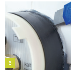
Odcięcie nadmiaru obudowy.
